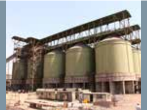
ساخت سیلو های ذخیره آهن اسفنجی
