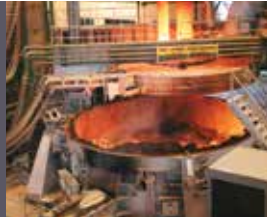
ساخت کوره قوس الکتریکی
