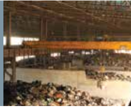
ساخت انبار قراضه
