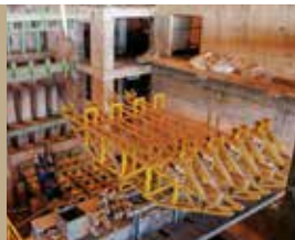
ساخت دامی بار و ماشین حمل دامی بار
